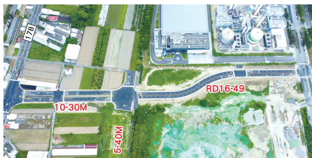
西北区北側連絡道 (RD16-49)
