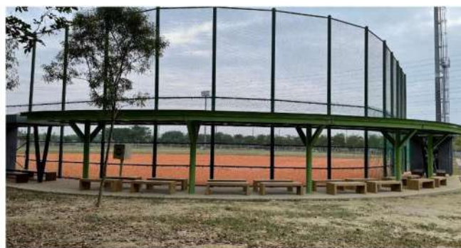
高雄園區公2運動公園ソフトボール場に日除け設置(2022年8月21日)
