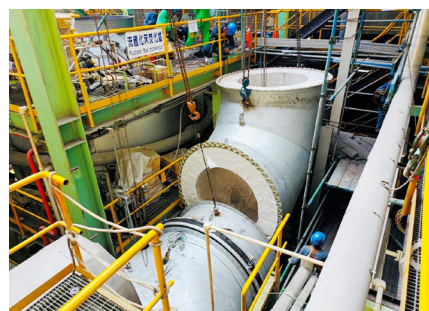
煙道の銅板および耐火材料の更新 (2022年10月12日)
