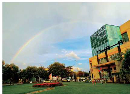
資源再生センター
